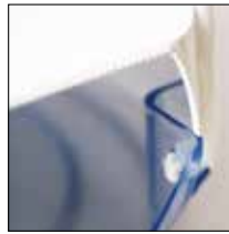
Abrisskanten im Vorder- und Seitenbereich
